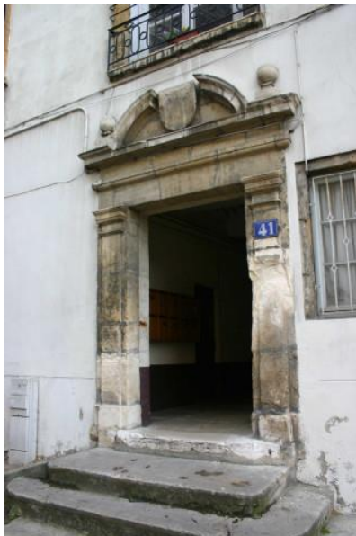
Façade du 41, rue des Farges
