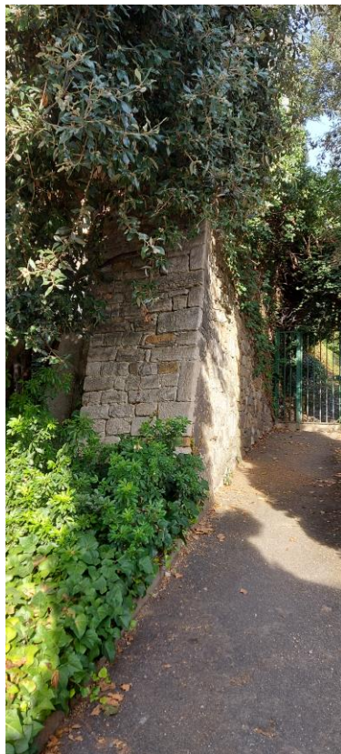
Portion du mur de la Retraite près de l'ancienne porte de Saint-Just. Photo P.P.
