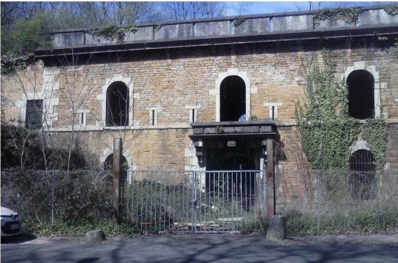
Entrée du fort de Loyasse
