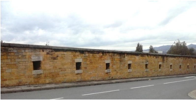
Le mur d'enceinte servant de clôture au cimetière ancien
